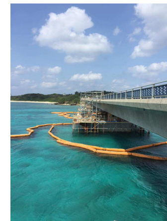
池間大橋, 沖縄県
